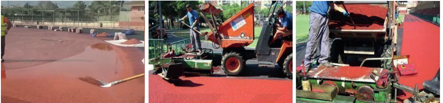
Proceso de Construcción
