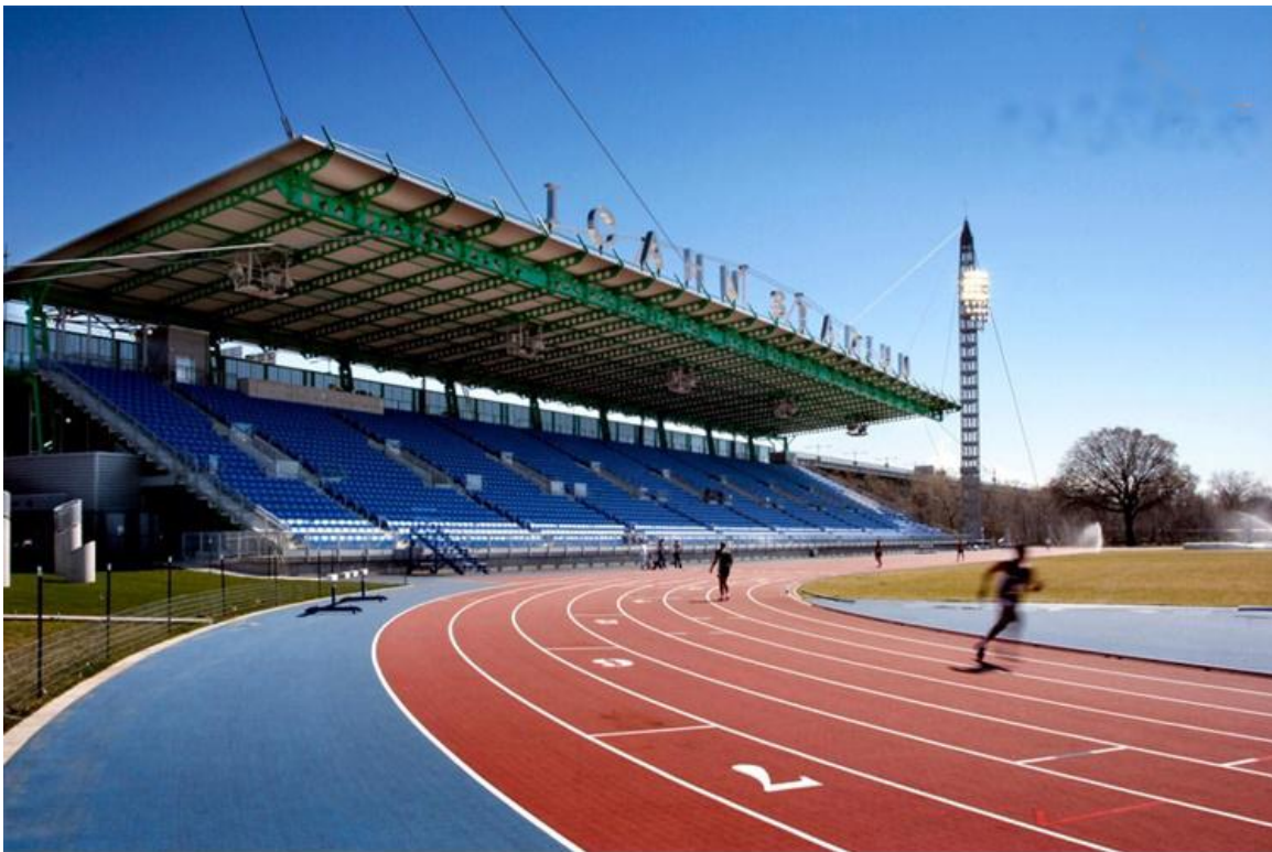
Fig. 09 Pista Atletica Sistema Sandwich Terminada.
