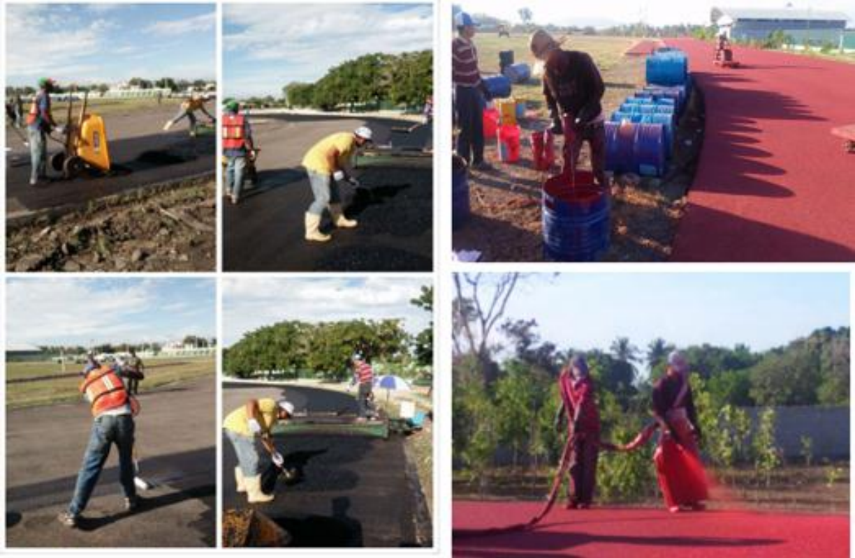
Proceso de Construcción. Fig. 1,2,3,4,6,
