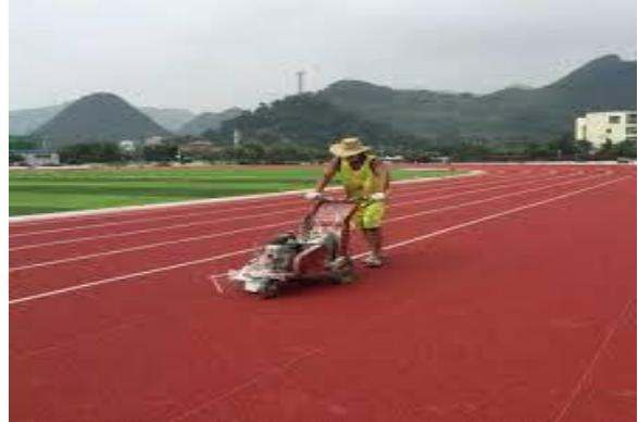
Fig. 03 Proceso de Construcción
