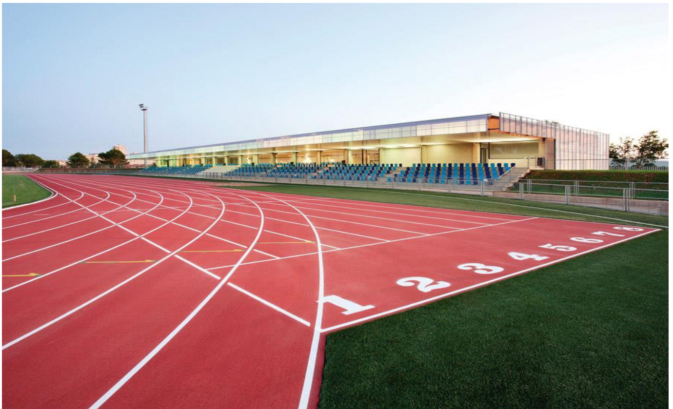
Fig. 07 Pista Atletica Sistema Sandwich Terminada.
