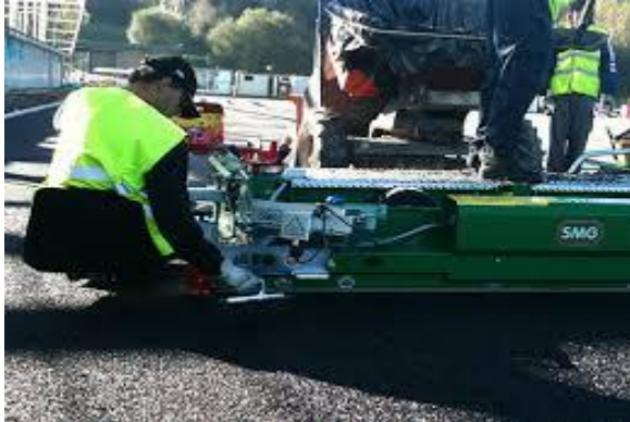
Fig. 02 Proceso de Construcción
