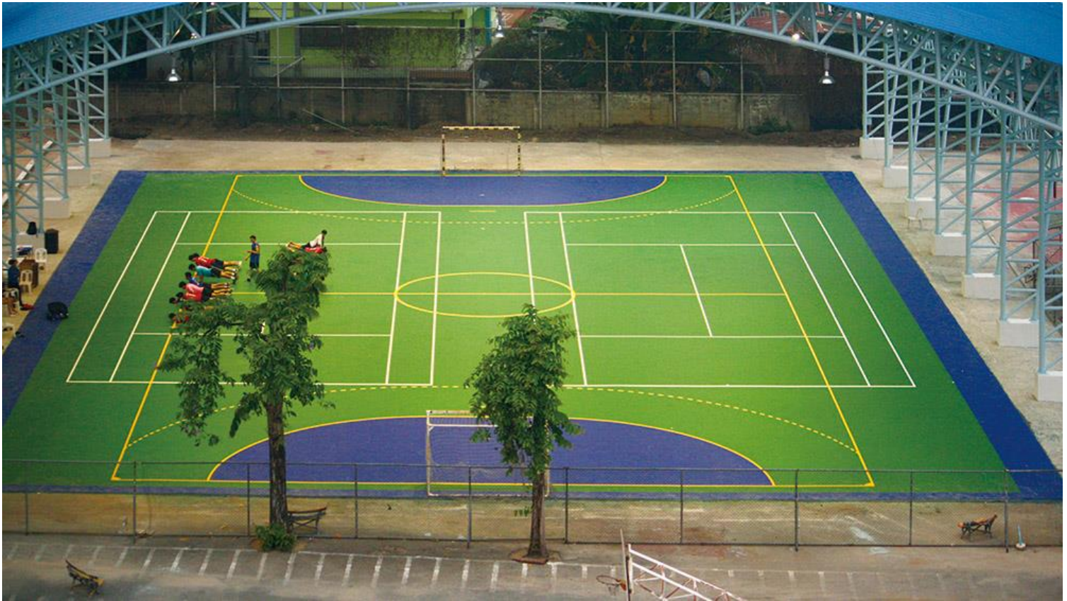
Fig. 19 Pavimento Deportivo de Poliuretano. (Cancha Multideportiva)
